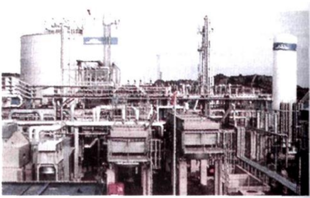
4-rasm. Kollsness shahridagi (Norvegiya) STG ni olish qurilmasining ko‘rinishi, ish unumdorligi 4,5 t/soat.
